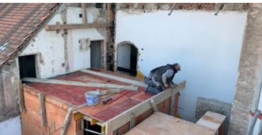
Auf der rückwärtigen Seite des Kirchenschiffs sind die Betonarbeiten an der neuen Empore abgeschlossen. Sie kommt ohne störende Säulen aus und hält Abstand zu den seitlichen Fenstern, so dass nun viel mehr Licht in den Eingangsbereich fällt. Die Betontreppen auf beiden Seiten erlauben einen bequemen und sicheren Zugang.
