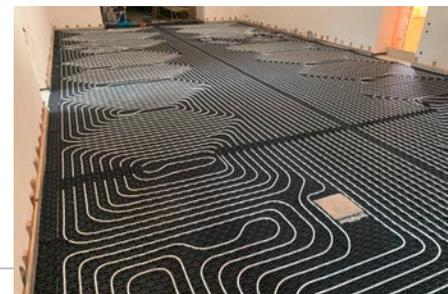
Foto: Die Schleifen der Fußbodenheizung Im Kirchenschiff und auf der Empore
